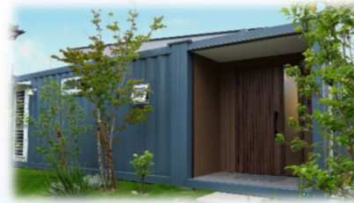
コンテナハウス
