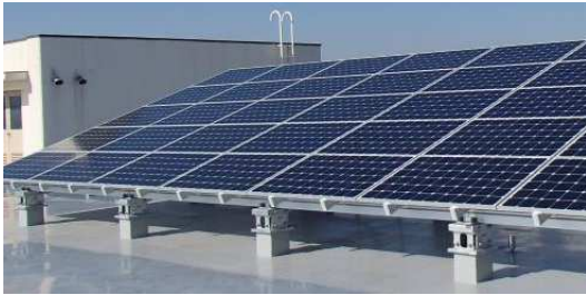
5) 公共設備、病院、宿泊施設、工場屋根上
